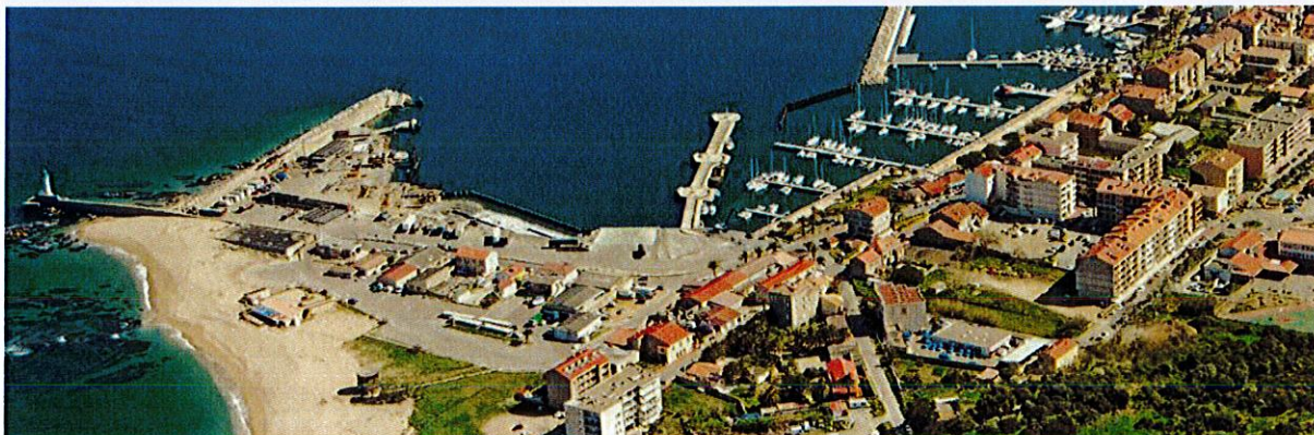
Vue aérienne du secteur U1a, du port de commerce, de pêche et de plaisance, et du centre-ville de Propriano
