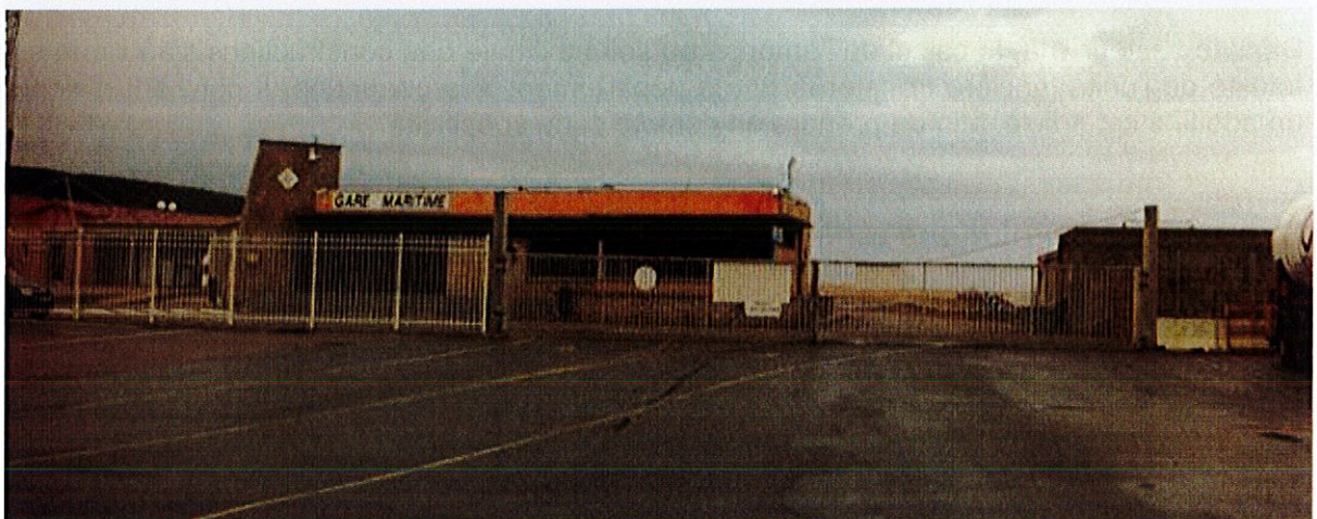
Vues du secteur U1a, à partir du port de commerce (en premier plan, le quai l'Herminier)
