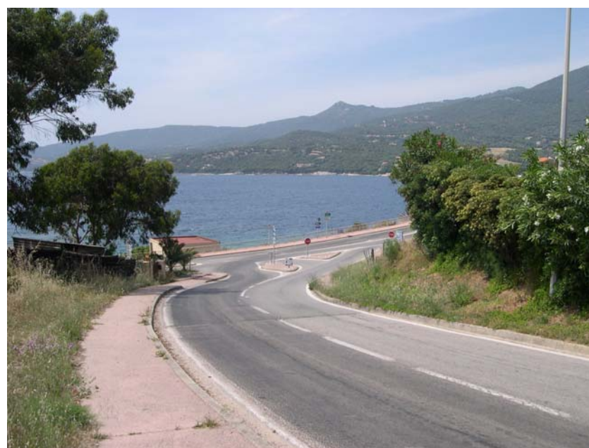
La corniche, vue depuis la RD19 (carrefour à requalifier)
