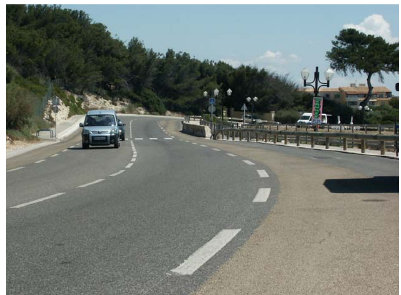
Exemple de corniche aménagée avec voirie « en plateau » (Sausset – 13)
